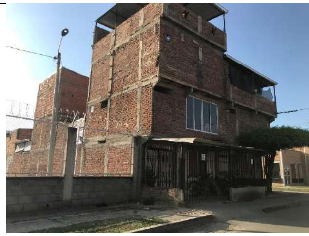
Fotografía 7 Viviendas que colindan con el predio sujeto a intervención
